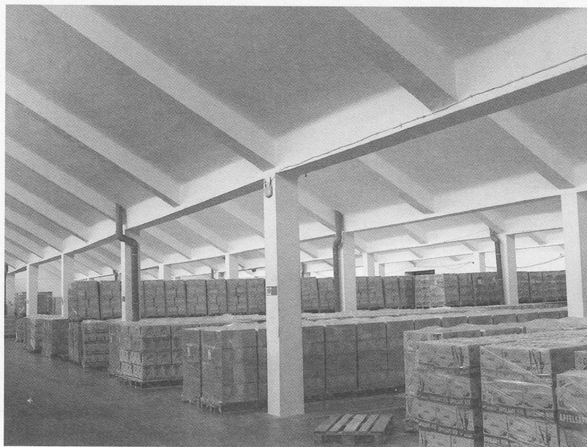
Hala magazynowa Firmy Sokpol – przykryta dachem szedowym (fot. J. Durka)
