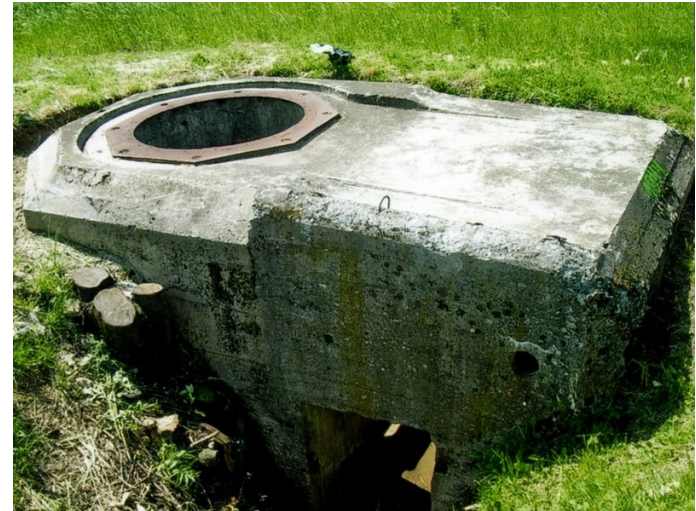
Żerkowice – linia fortyfikacji bojowej z 1944 r., schron „Ringstand 238”, fot. Maciej Świdorski
