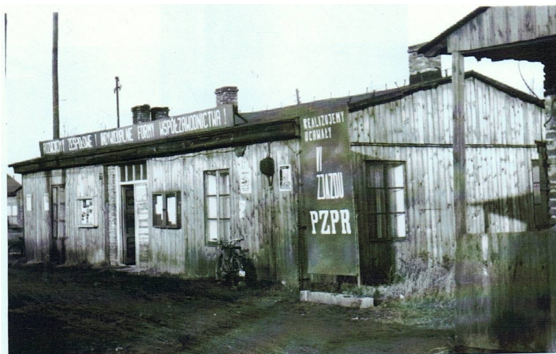
Budynek biurowy kopalni.
