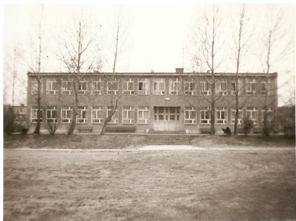
Budynek szkoły z roku 1969
